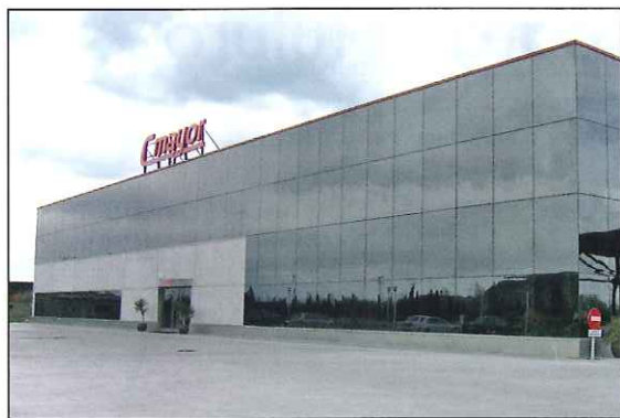
Instalaciones de Carretillas Mayor, en cuya construcción ha participado 1A Ingenieros.
