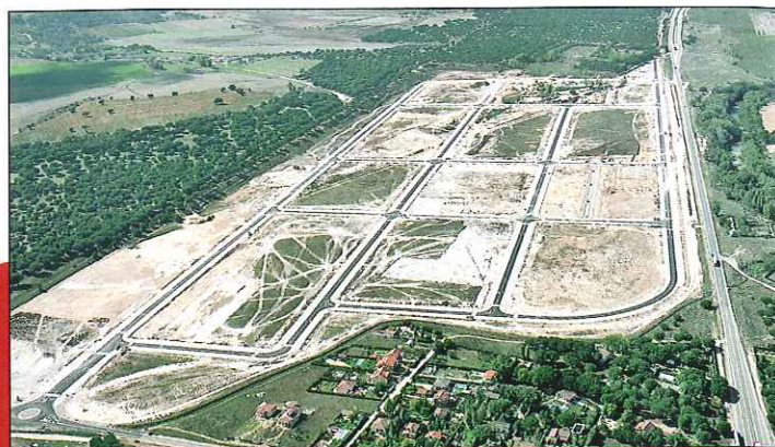
El Polígono Tudero se ubica en Tudela de Duero (Valladolid).
